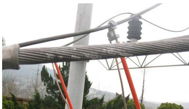
图 3 1 号变压器 35kV 侧 A 相套管引线放电痕迹照片
