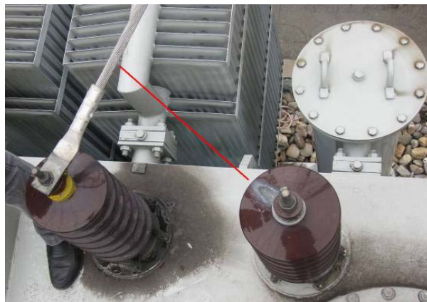
图 2 1 号变压器中性点套管放电痕迹照片
